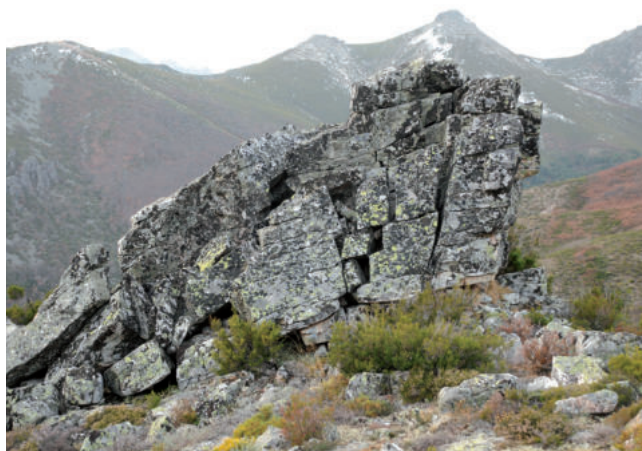
Fig. 2.1.3. Afloramiento intensamente fracturado y en parte derrumbado.
