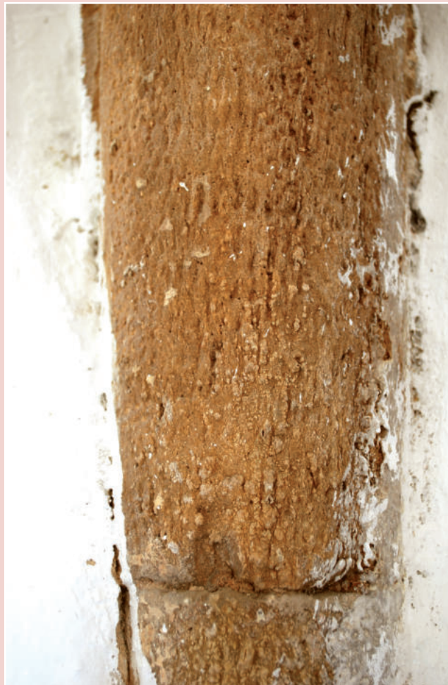
Fig. 3.2.31. Detalle de un nervio del pórtico de la ermita del Buen Suceso.
