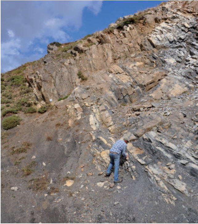
Fig. 1.6.11. Detalle del cabalgamiento del valle de La Tercia, concretamente de su parte frontal.
