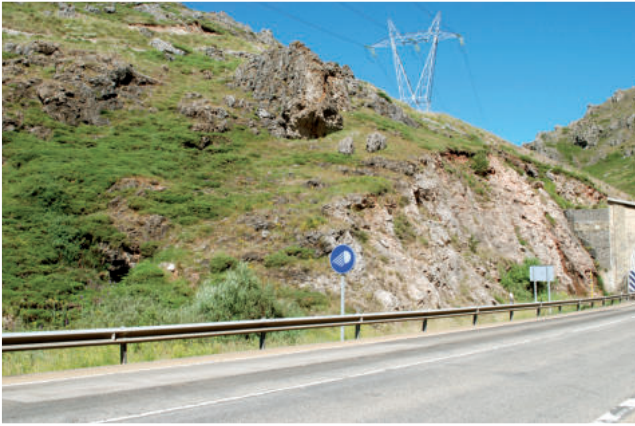
Fig. 3.1.21. Situación de la mina de cobre. A la izquierda de la imagen se localiza la entrada a una de las galerías.
