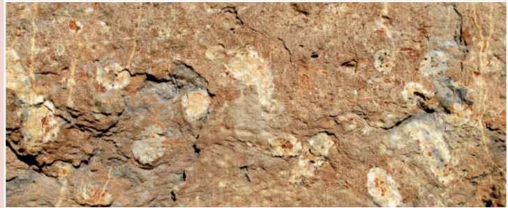
Fig. 3.2.33. Detalle de un sillar de la fachada de la capilla.
