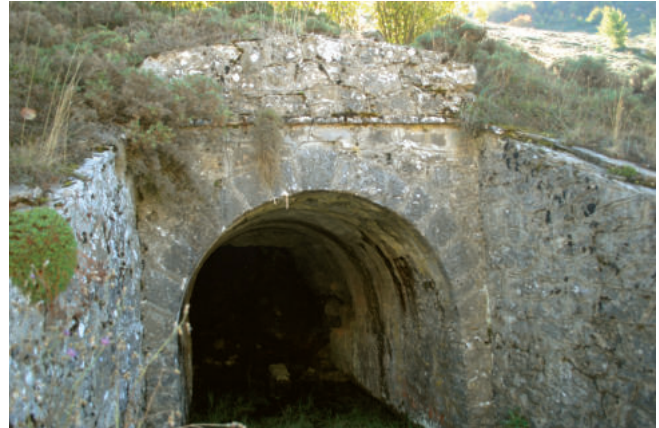
Fig. 3.1.4. Túnel de entrada a la galería inferior.
