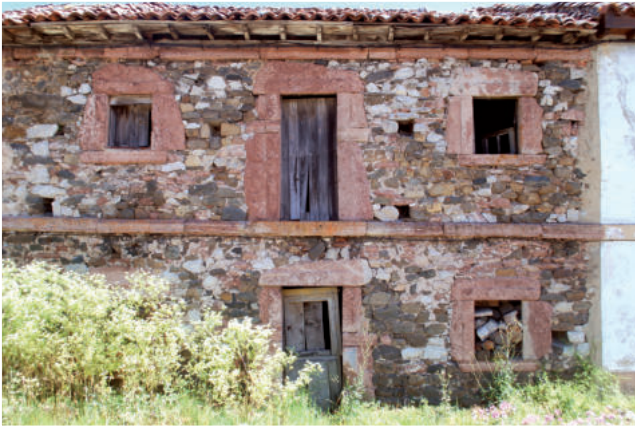
Fig. 3.2.25. Fachadas de las Casas de los Canónigos. Se han embellecido con la utilización de la caliza griotte en los marcos de puertas y ventanas.
