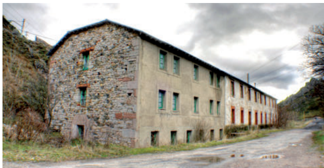
Fig. 3.4.1. Vista general del edificio ocupado por el antiguo balneario de Don Roque.
