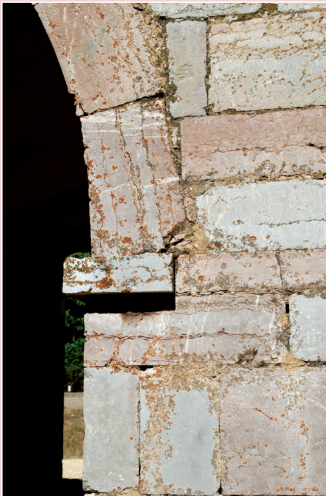
Fig. 3.2.27. Columna y arco de la ermita del Buen Suceso. Estas estructuras están realizadas con sillares muy bien labrados de la caliza roja carbonífera.
