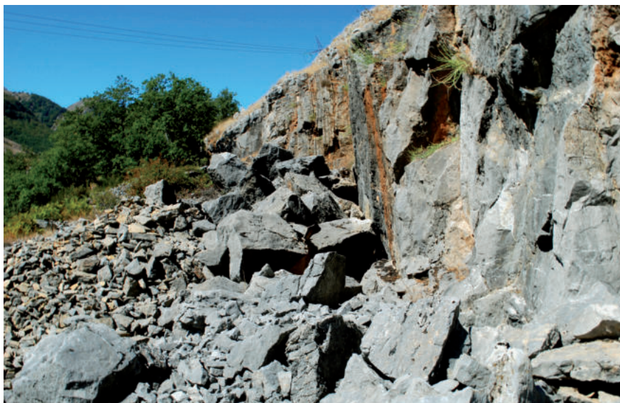
Fig. 3.2.11. Frente abandonado de la cantera de Cabornera, donde se explotaba caliza gris.
